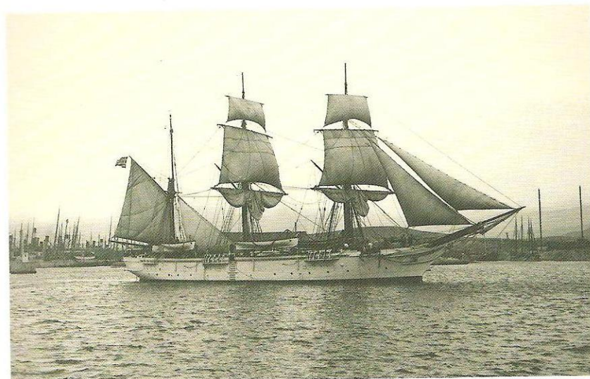
Φωτ. Νο 3: Ατμομυοδρόμων «Αλφειός». 400 τον. 10 κόμβ. Του ιδίου τύπου «Αχελώος», «Ευρώτας» και «Πηνειός». Ναυπηγήθηκαν το 1884-1885 στη Αγγλία. Διαστ. 130/25/13 πόδες. (από περιοδικό «ΠΕΡΙΠΛΟΥΣ ναυτικής ιστορίας» τεύχος Οκτωβρίου-Νοεμβρίου-Δεκεμβρίου)
